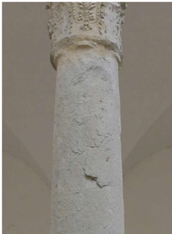
Figura 2-16 Superfici di sfaldatura con evidente perdita di materiale dalla colonna
