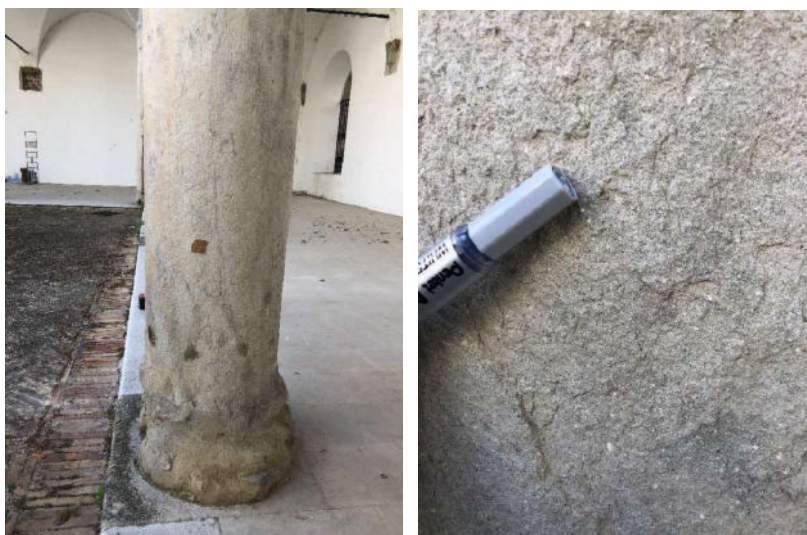
Figura 2-20 a) una delle colonne esaminate al Palazzo Ducale; b) particolare della colonna in arenaria.
