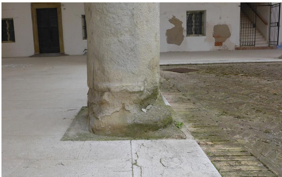
Figura 7.4 - Degrado superficiale e patina biologica sul basamento di una colonna
