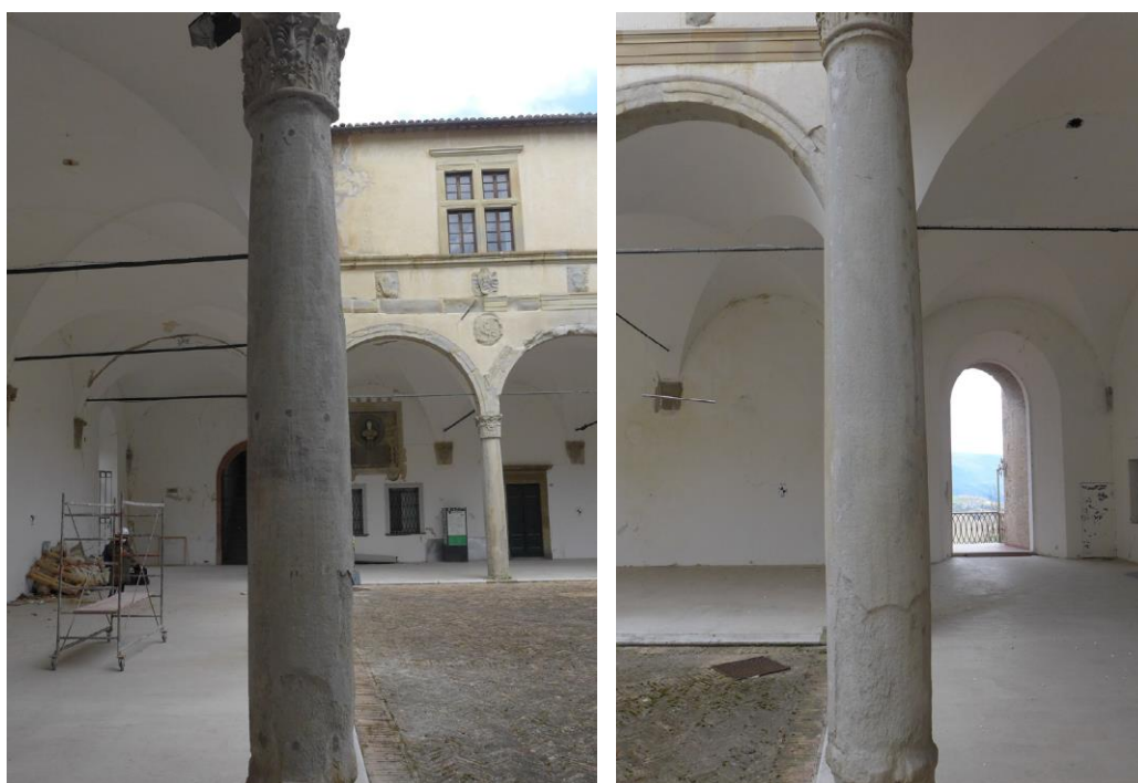
Figura 7.3 - Degrado superficiale delle colonne del quadriportico lungo il fusto
