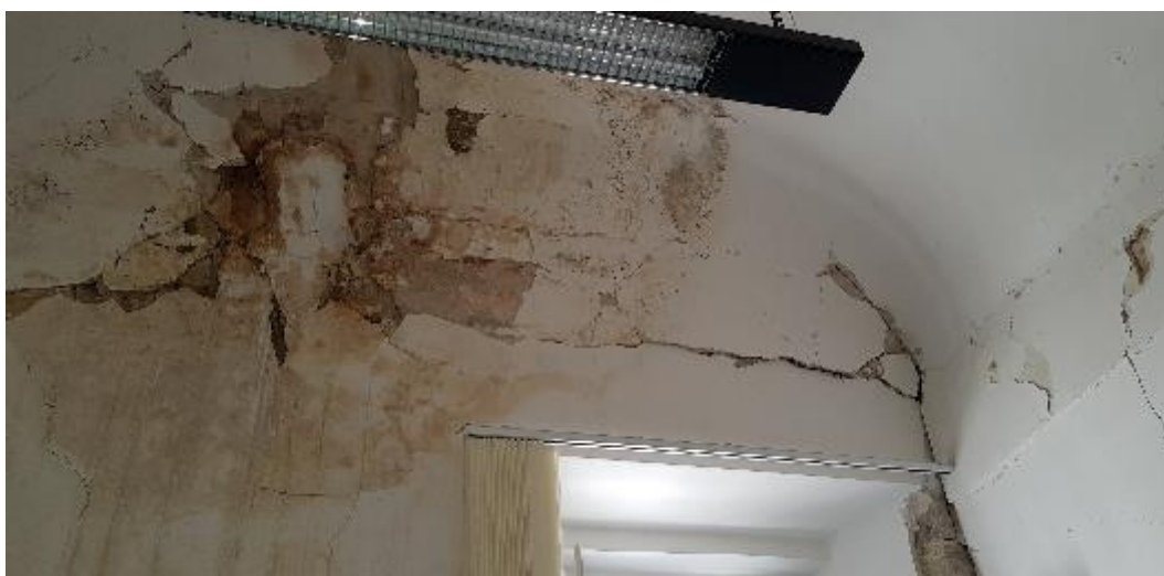
Figura 3.17 - Distacco del soffitto in camorcanna dalle pareti e locali infiltrazioni d'acqua
