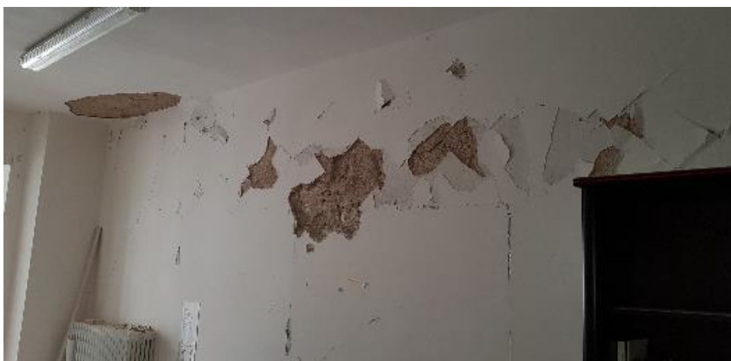
Figura 2.16 - Fessurazione lungo i bordi di nicchie richiuse
