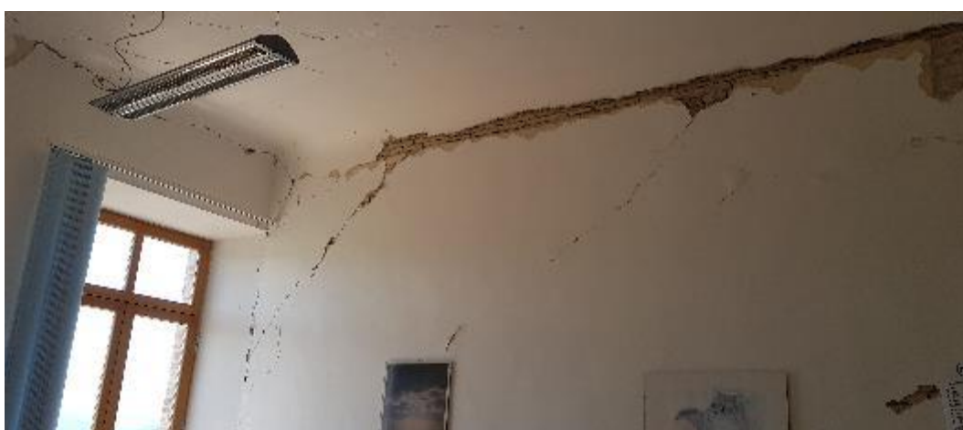
Figura 2.10 - Lesioni a taglio sui divisori ortogonali alla parete di Figura 2.9
