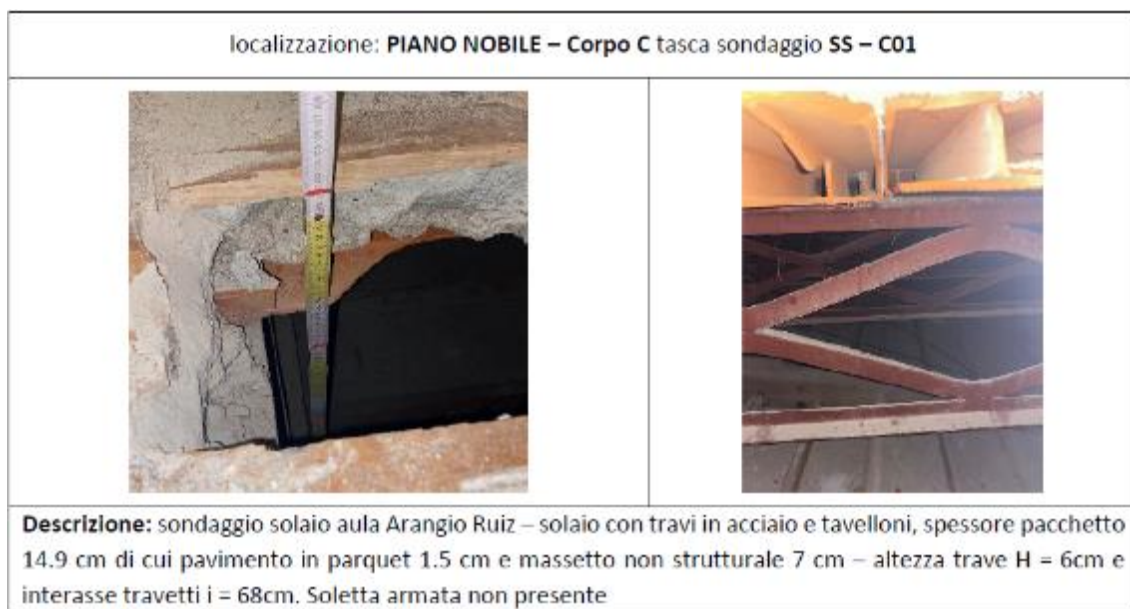
Fig. 4.26 - Rimozione locale della pavimentazione in corrispondenza dell'Aula Arangio-Ruiz al Piano Nobile del Corpo C
