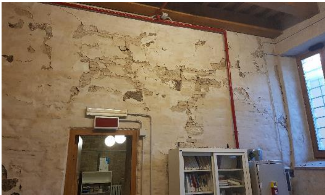
Figura 2.30 - Quadro fessurativo caratteristico del Corpo C
