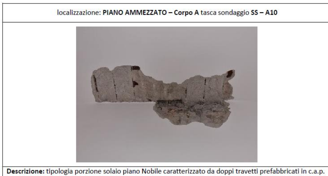
Figura 4.15 - Rimozione di intonaco all'intradosso del solaio di calpestio del Piano Nobile, dove sono ben visibili gli estradossi dei doppi travetti in c.a.p.
