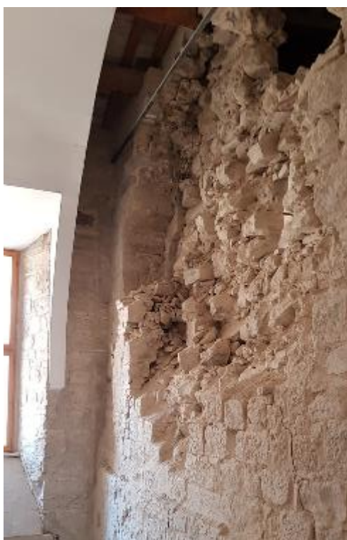
Figura 3.54 - Crollo della parte alta della parete: è ben visibile la separazione tra i due paramenti murari e il riempimento in materiale sciolto
