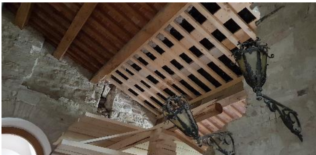
Figura 3.27 - Porzione di parete crollata e messa in sicurezza della copertura
