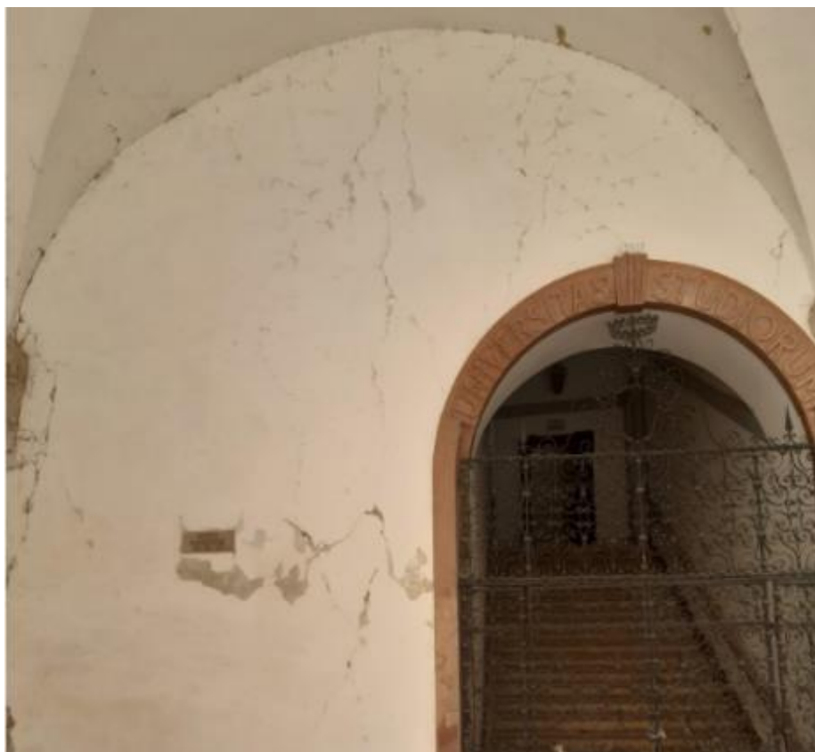
Figura 3.14 - Fessurazione diffusa del paramento murario perimetrale lato nord del Quadriportico: sono visibili una serie di lesioni ad X in corrispondenza della porzione di maschio murario adiacente all'apertura
