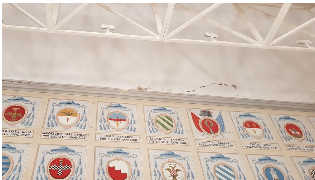
Figura 3.47 - Distacco tra il controsoffitto in cartongesso e la parete
