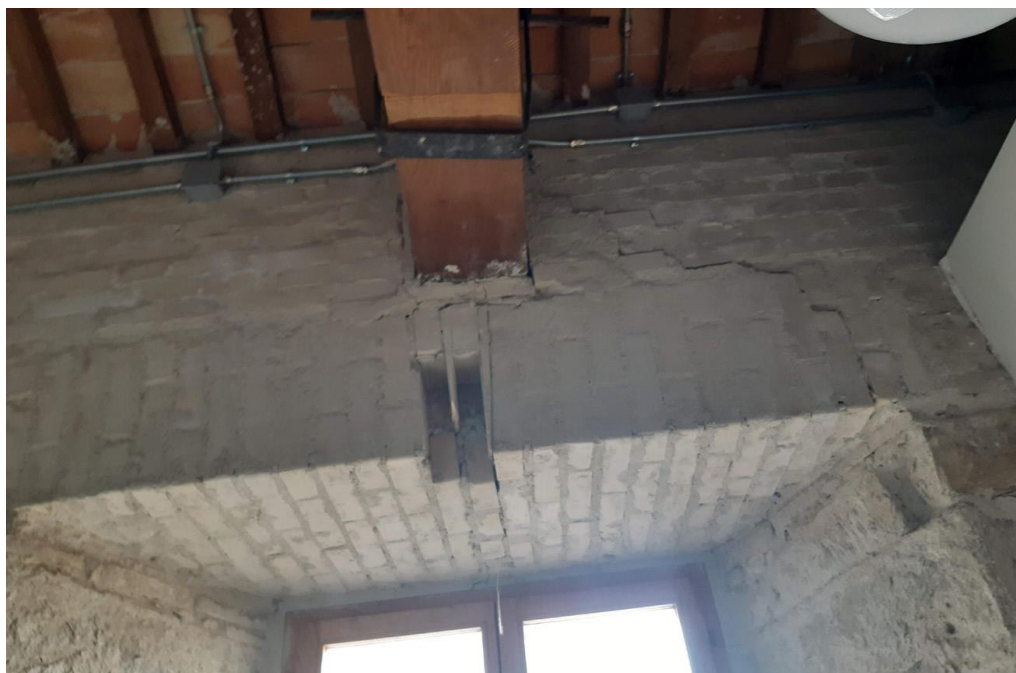
Figura 3.51 - Appoggio della trave in legno sull'architrave in muratura di mattoni
