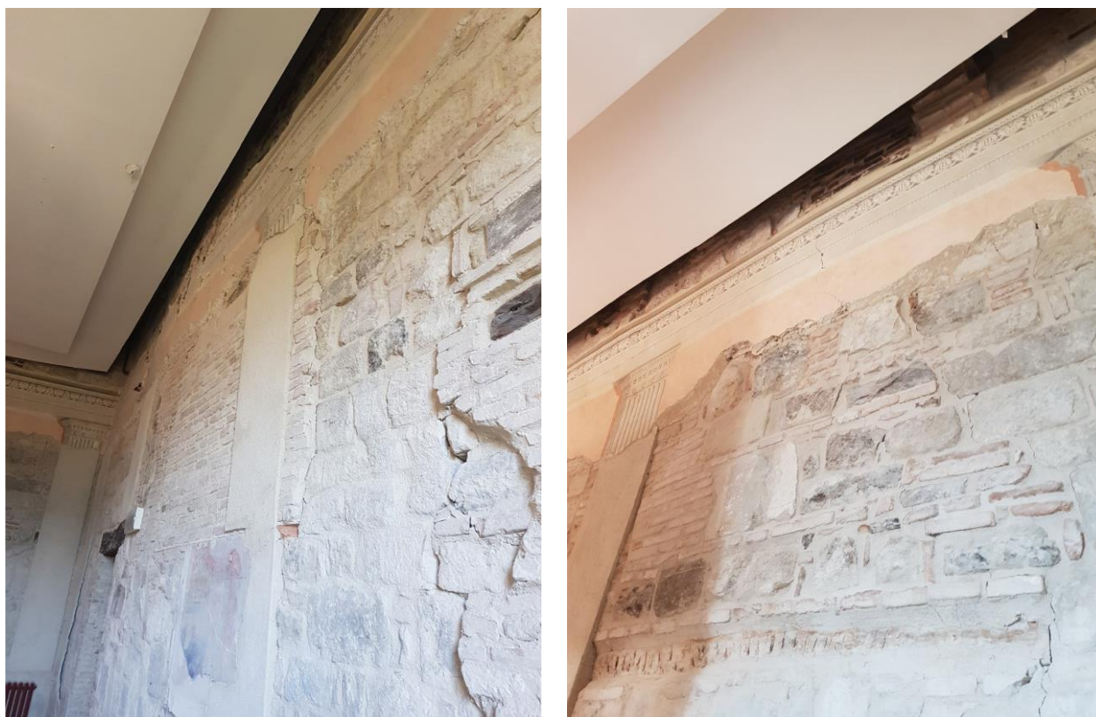
Figura 2.41 - Fuori piombo delle pareti della Sala degli Stemmetti
