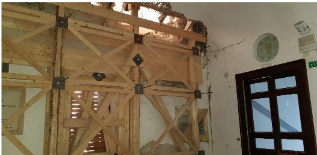
Figura 3.13 - Porzione di parete crollata vista dall'interno
