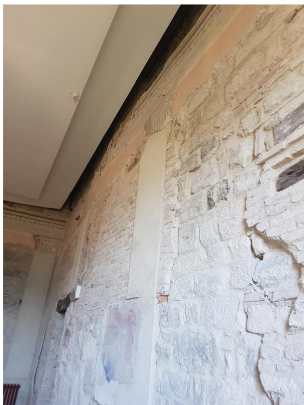
Figura 3.40 - Fuori piombo delle pareti della Sala degli Stemmetti
