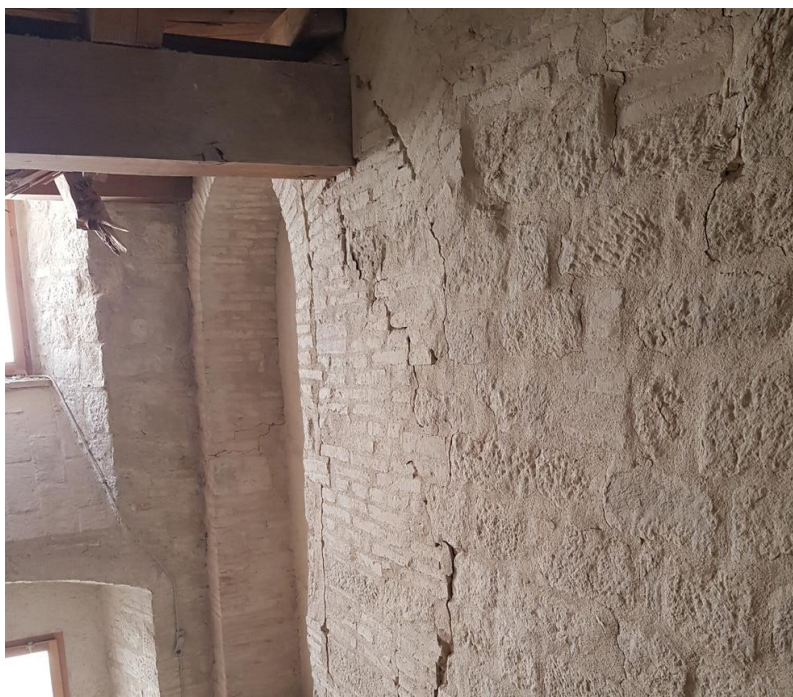
Figura 3.53 - Dettaglio del collegamento puntuale della scala in legno alla parete e di un vano richiuso
