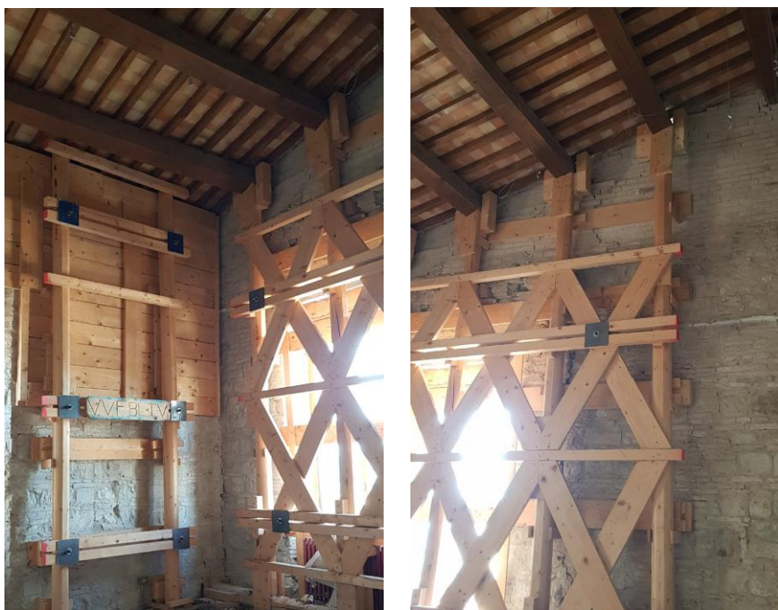
Figura 2.59 - Crollo dell'angolata e messa in sicurezza dei VVF
