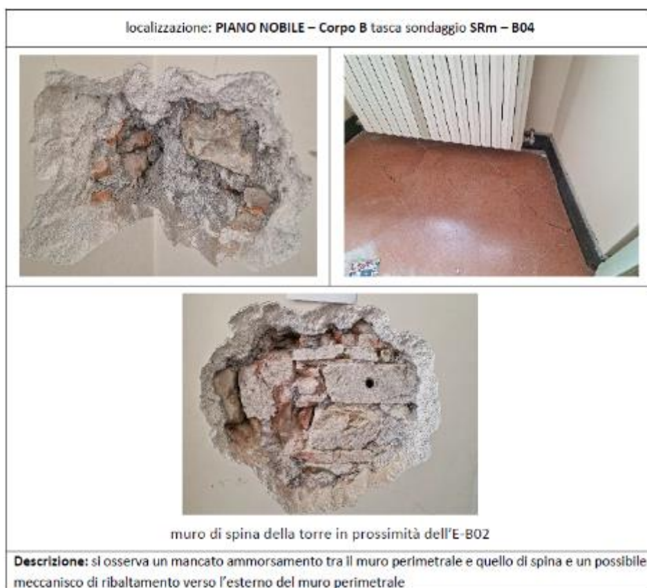
Figura 4.8 – Possibile meccanismo di ribaltamento della parete perimetrale visibile dalla fessura sulla pavimentazione
