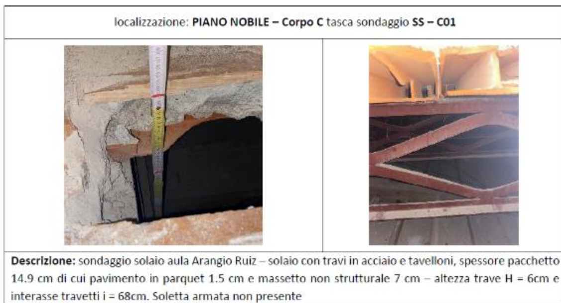
Fig. 3.26 - Rimozione locale della pavimentazione in corrispondenza dell'Aula Arancio-Ruiz al Piano Nobile del Corpo C
