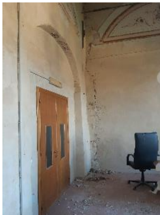
Figura 3.35 - Dettaglio del quadro fessurativo nel vano della scala a chiocciola
