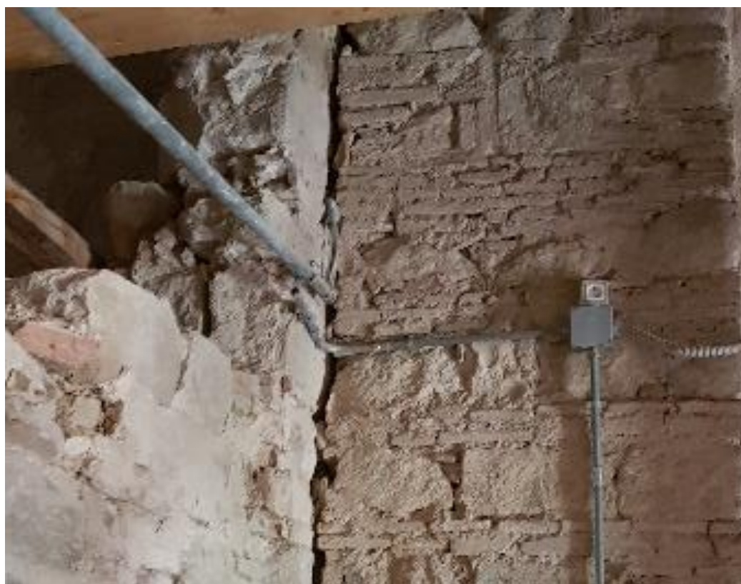
Figura 2.26 – Lesione verticale per mancanza di ammortamento
