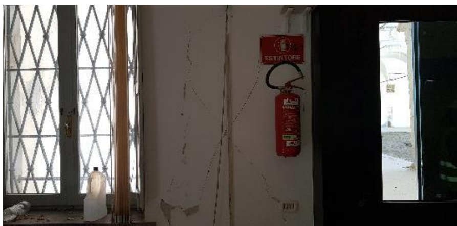
Figura 2.3 - Fessurazione a X di un maschio murario nella zona tra due aperture
