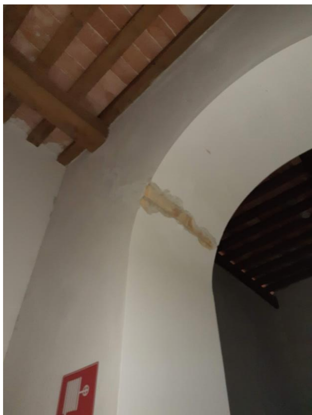
Figura 3.61 - Quadro fessurativo degli archi del piano Ammezzato
