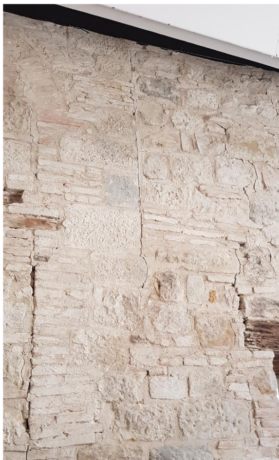
Figura 2.29 - Lesioni diffuse sulle pareti della torre
