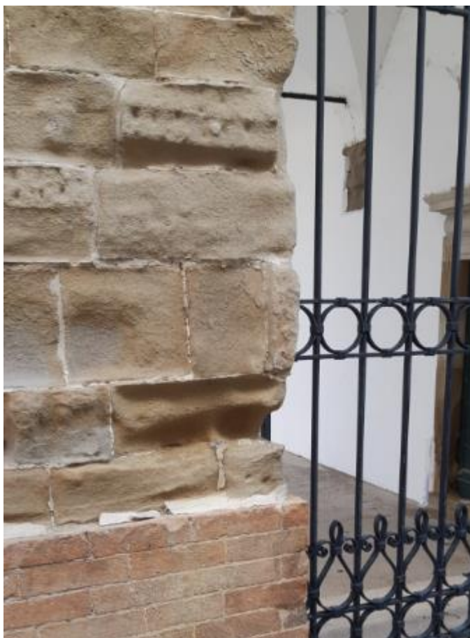
Figura 3.21 - Significativa riduzione dello spessore degli elementi in arenaria sulla parete lato Piazza
