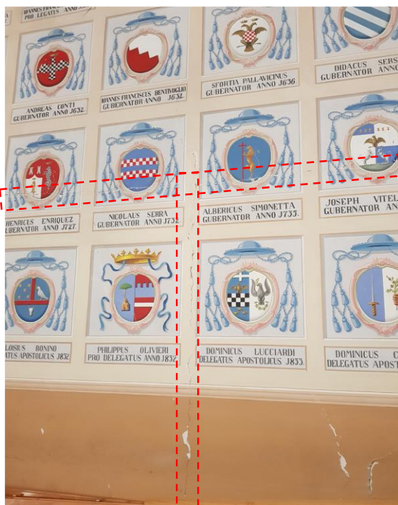
Figura 2.45 – Lesione orizzontale a livello del solaio delle sale adiacenti e verticale a livello delle pareti ortogonali delle sale adiacenti
