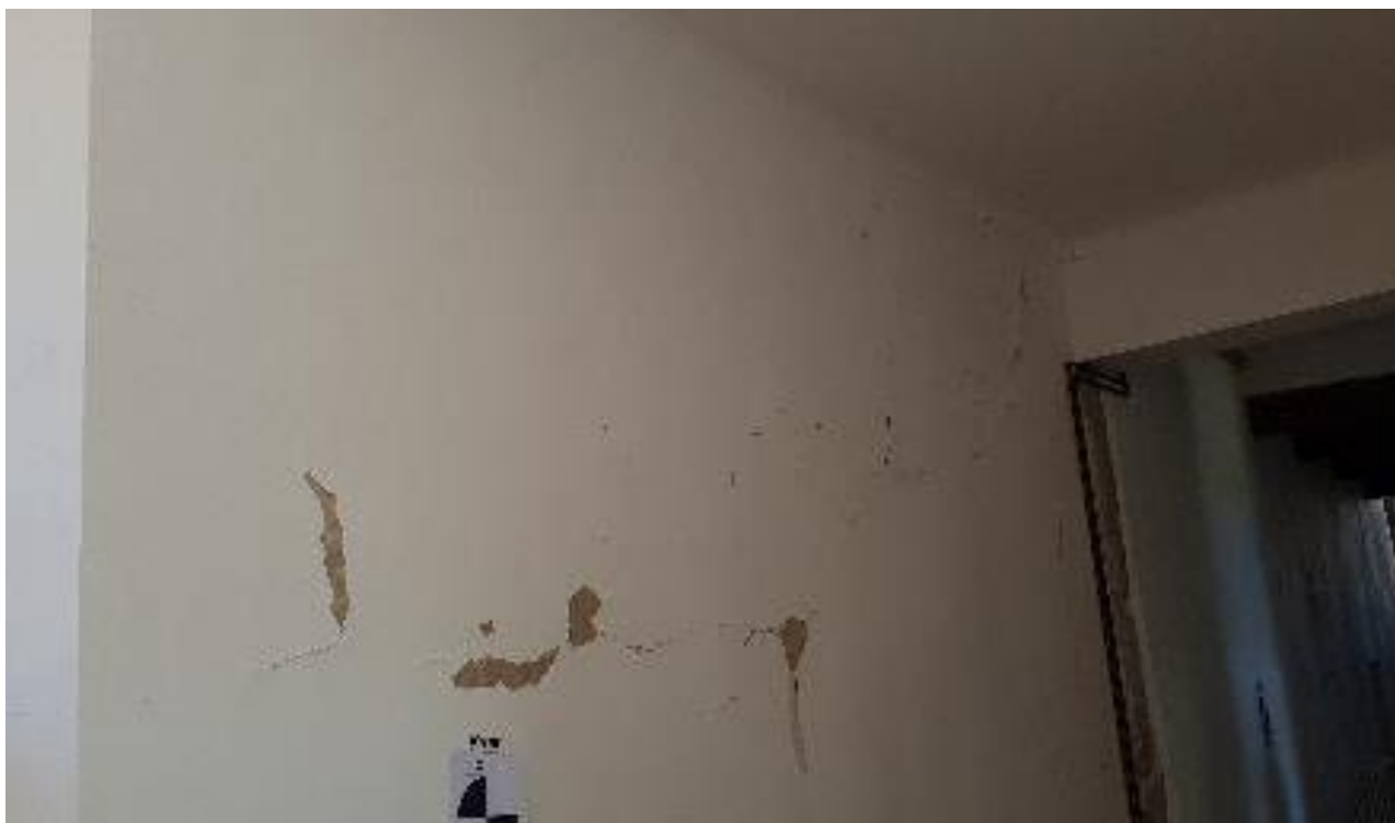
Figura 3.5 - Fessurazione diagonale su una parete del piano nobile
