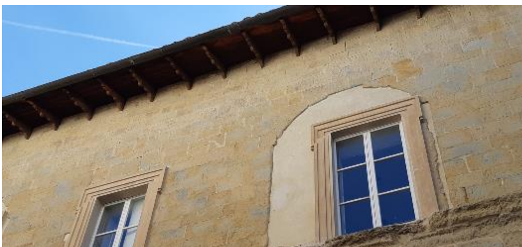
Figura 3.19 – Lesioni diffuse nella parte alta delle pareti per la bassa entità del carico verticale agente
