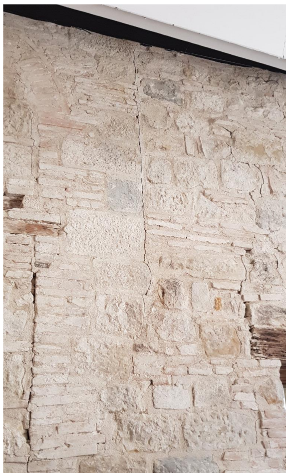
Figura 3.28 - Lesioni diffuse sulle pareti della torre
