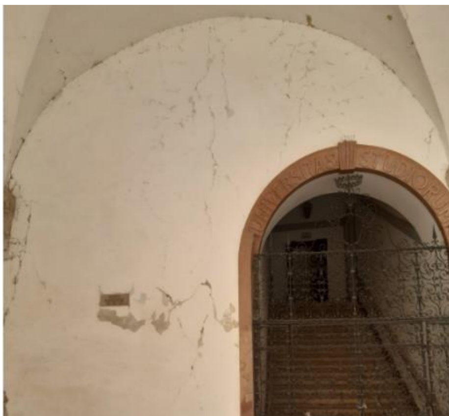
Figura 2.15 - Fessurazione diffusa del paramento murario perimetrale lato nord del Quadriportico: sono visibili una serie di lesioni ad X in corrispondenza della porzione di maschio murario adiacente all'apertura
