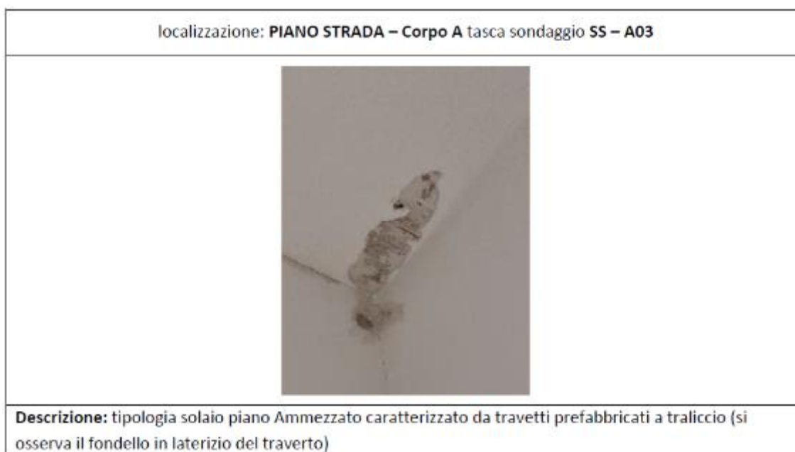
Figura 4.17 - Rimozione intonaco all'intradosso del solaio di calpestio del piano Ammezzato
