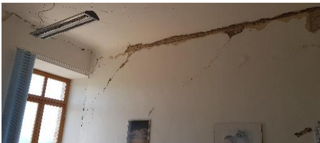
Figura 3.9 - Lesioni a taglio sui divisori ortogonali alla parete di Figura 3.8
