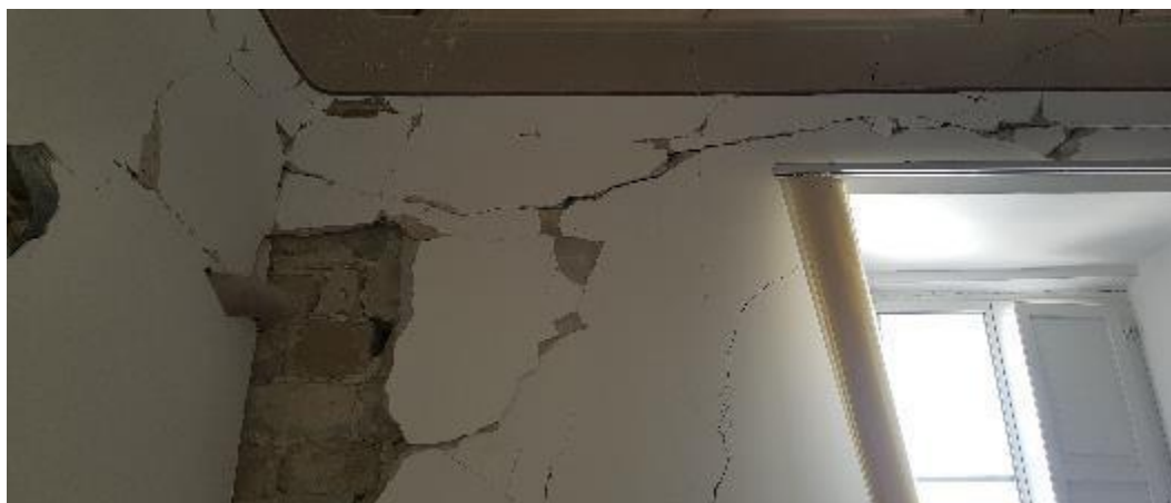
Figura 2.19 - Distacco dello spesso strato di intonaco superficiale dalla parete in arenaria
