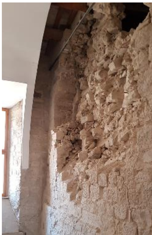
Figura 2.55 - Crollo della parte alta della parete: è ben visibile la separazione tra i due paramenti murari e il riempimento in materiale sciolto
