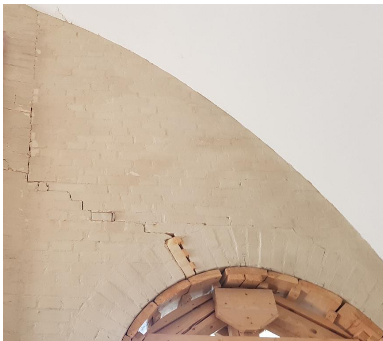
Figura 3.62 - Quadro fessurativo degli archi del piano Nobile e messa in sicurezza da parte dei VVF
