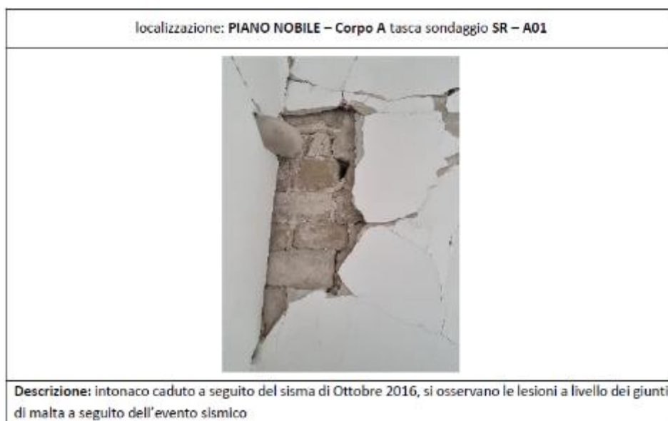
Figura 4.7 - Rimozione di intonaco sulla parete perimetrale lato piazza
