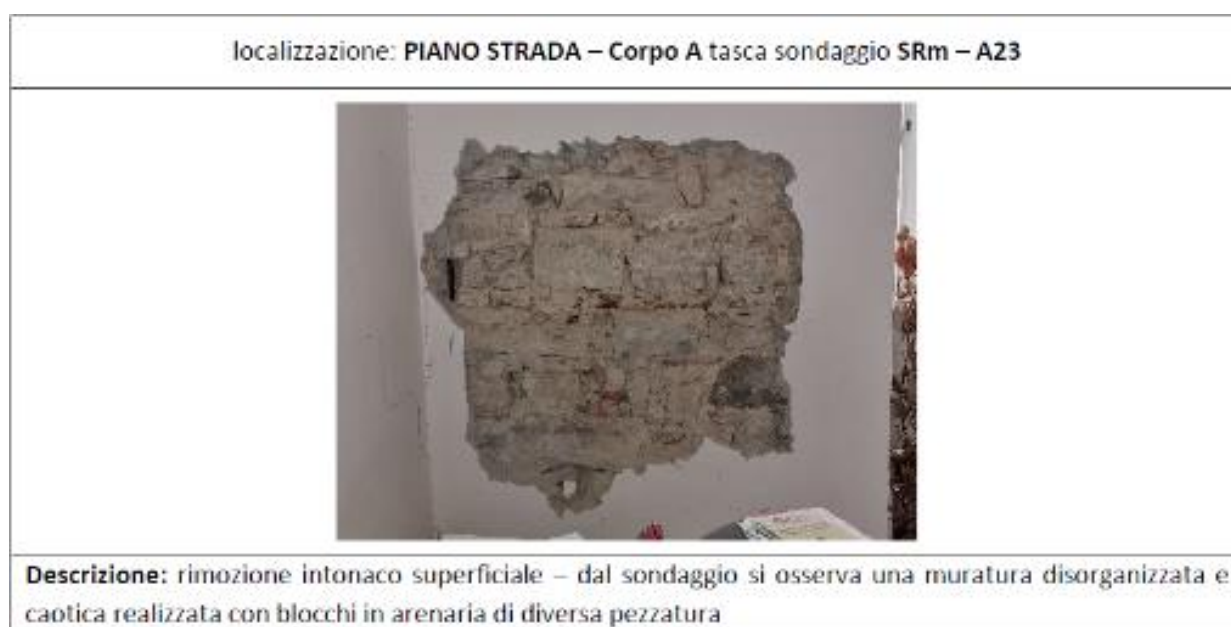
Figura 4.3 - Rimozione di intonaco su una delle pareti perimetrali del Piano Nobile
