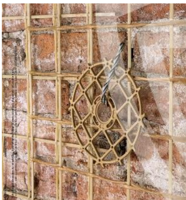
Figura 4.15 - Particolare intonaco armato con barre passanti elicoidali e rete in fibra di vetro
