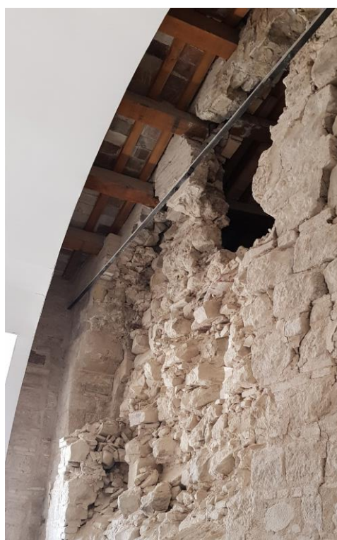
Figura 3.54 - Crollo della parte alta della parete: è ben visibile la separazione tra i due paramenti murari e il riempimento in materiale sciolto
