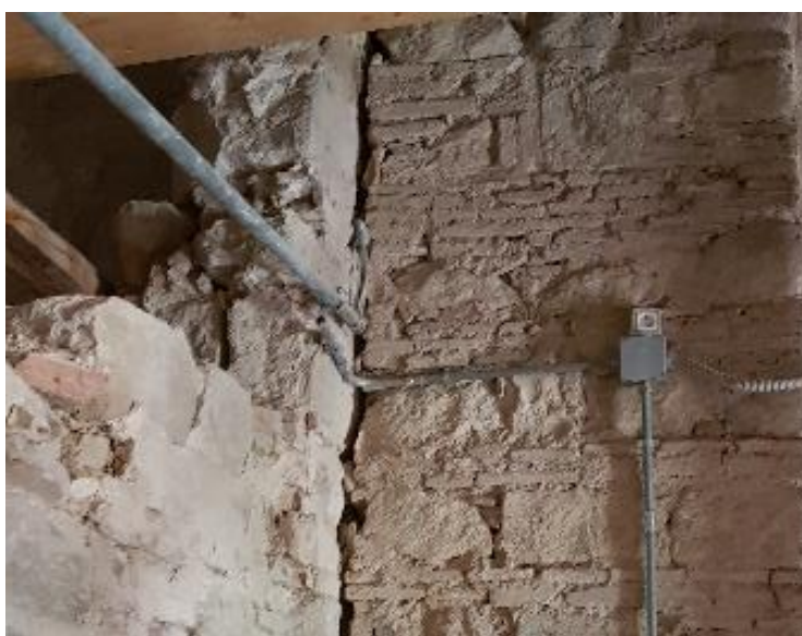
Figura 3.25 – Lesione verticale per mancanza di ammortamento
