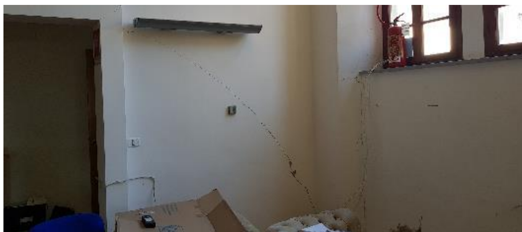
Figura 3.7 - Lesione legata al principio di ribaltamento della parete perimetrale lato portico
