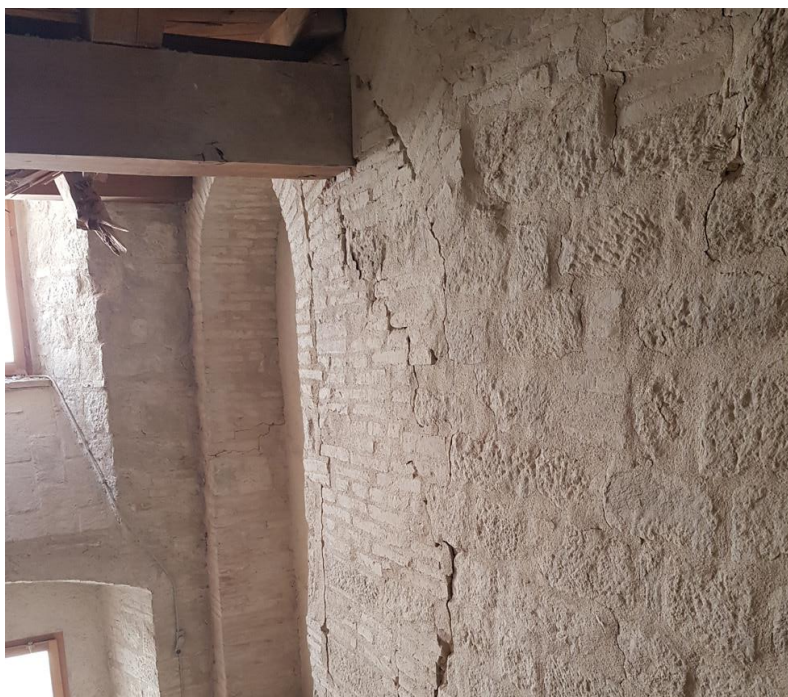
Figura 2.54 - Dettaglio del collegamento puntuale della scala in legno alla parete e del quadro fessurativo in cui è ben evidente la disomogeneità della tessitura muraria
