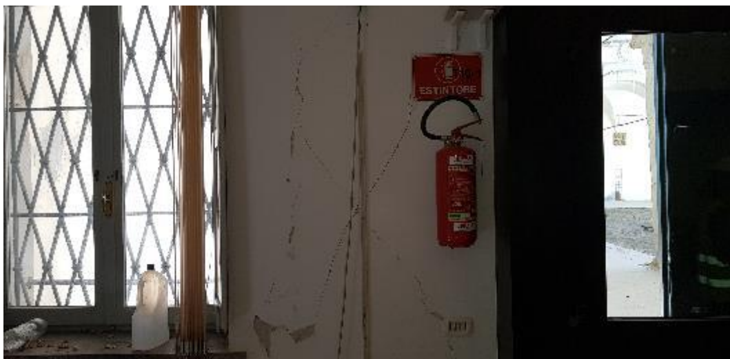
Figura 3.3 - Fessurazione a X di un maschio murario nella zona tra due aperture
