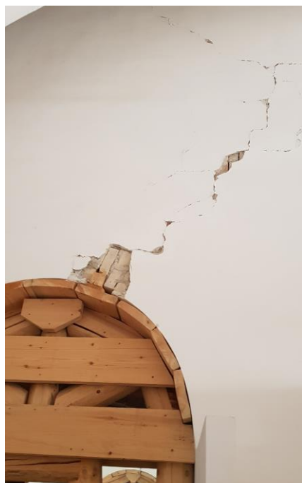
Figura 3.62 - Quadro fessurativo degli archi del piano Nobile e messa in sicurezza da parte dei VVF
