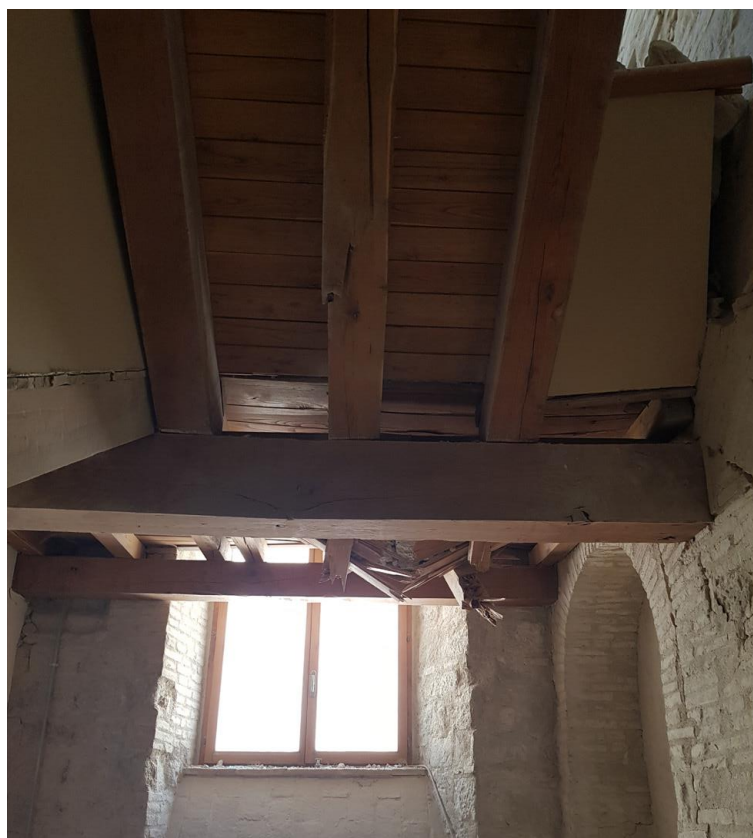
Figura 3.56 - Accumulo delle macerie sul pianerottolo della scala in legno in seguito al crollo della parete soprastante
