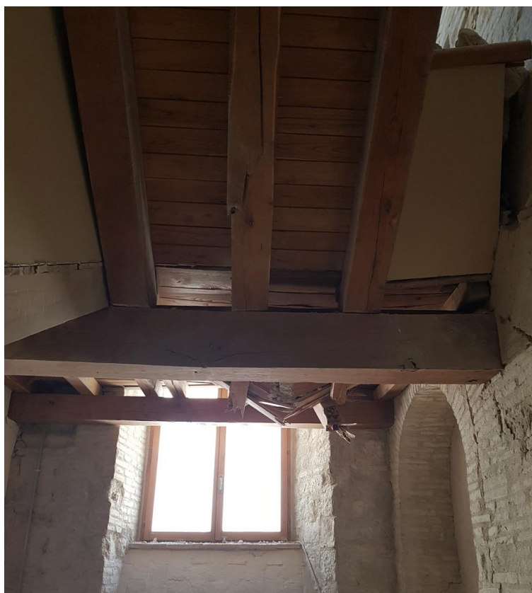
Figura 2.57 - Accumulo delle macerie sul pianerottolo della scala in legno in seguito al crollo della parete soprastante
