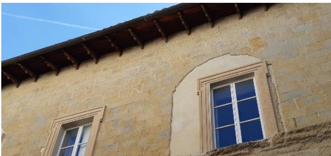
Figura 2.20 – Lesioni diffuse nella parte alta delle pareti per la bassa entità del carico verticale agente
