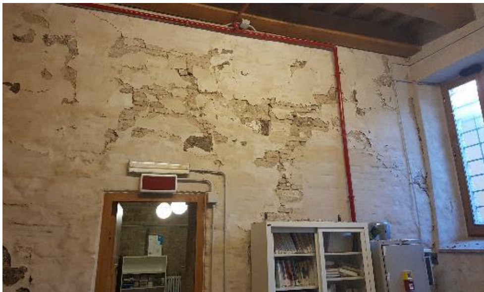
Figura 3.29 - Quadro fessurativo caratteristico del Corpo C
