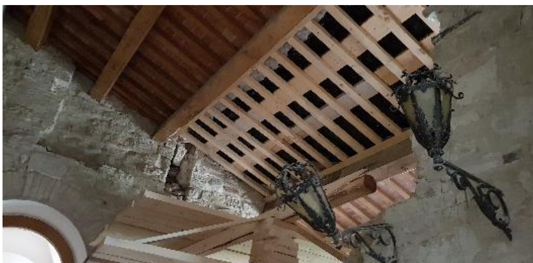
Figura 2.28 - Porzione di parete crollata e messa in sicurezza della copertura
