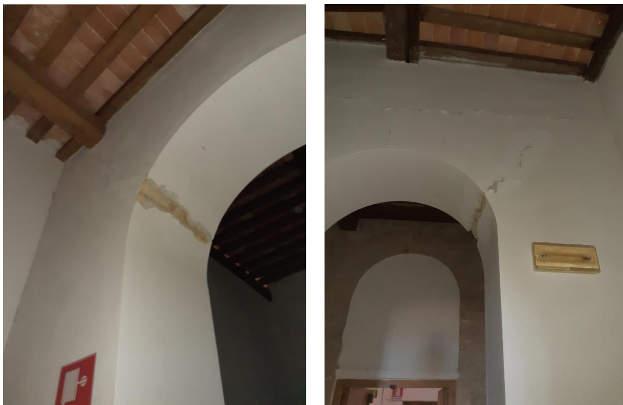
Figura 2.62 - Quadro fessurativo degli archi del piano Ammezzato
