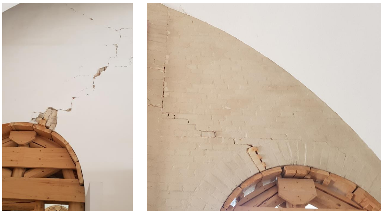
Figura 2.63 - Quadro fessurativo degli archi del piano Nobile e messa in sicurezza da parte dei VVF
