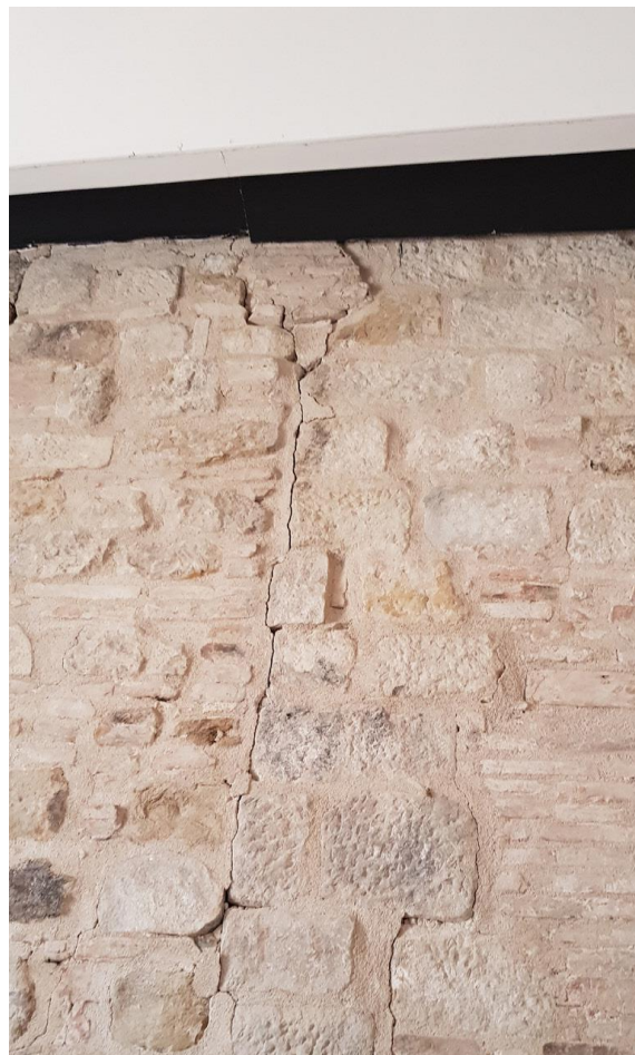
Figura 3.28 - Lesioni diffuse sulle pareti della torre
