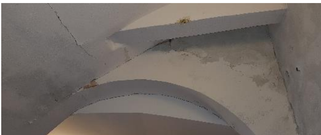
Figura 3.20 - Lesioni nei punti di collegamento tra il corpo scala e l'arcata superiore di un'apertura
