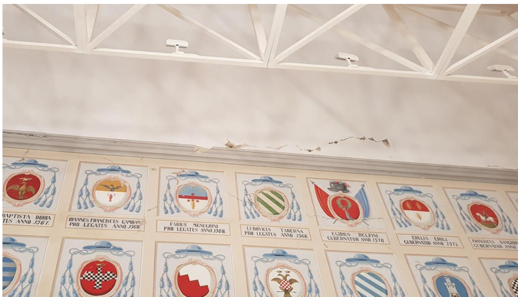
Figura 2.48 - Distacco tra il controsoffitto in cartongesso e la parete
