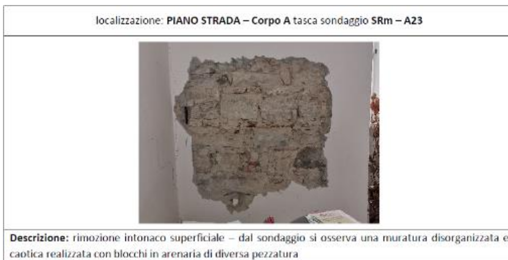
Figura 3.3 - Rimozione di intonaco su una delle pareti perimetrali del Piano Nobile
