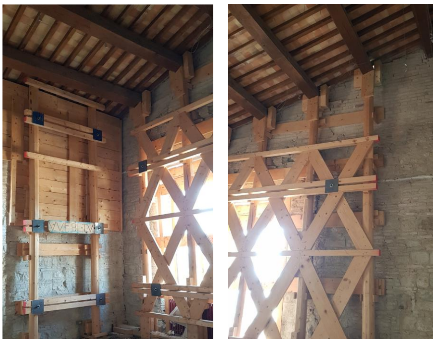
Figura 3.58 - Crollo dell'angolata e messa in sicurezza dei VVF
