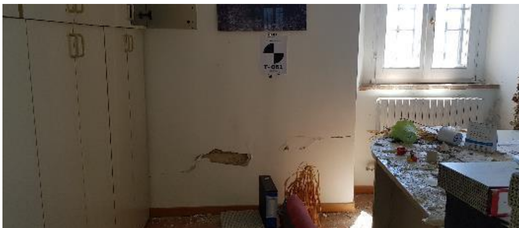
Figura 3.8 – Lesione sub-orizzontale a circa 50 cm al di sopra della pavimentazione della parete Est lato Orto Botanico
