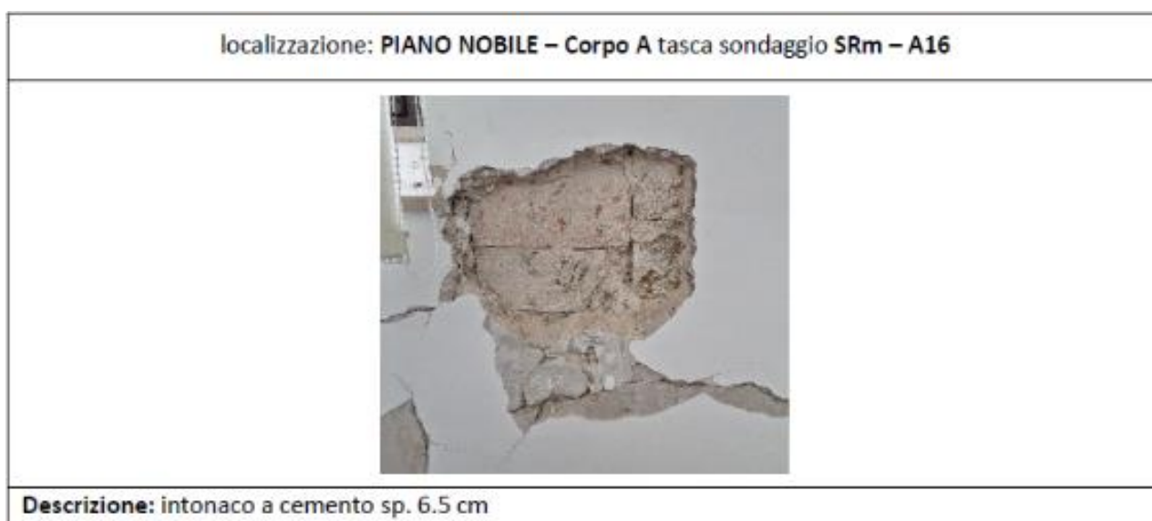
Figura 4.6 - Rimozione di intonaco sulla parete interna lato Quadriportico
