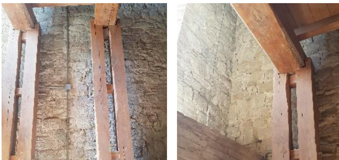
Figura 3.23 - Lesioni diffuse in corrispondenza della base del vano scala
