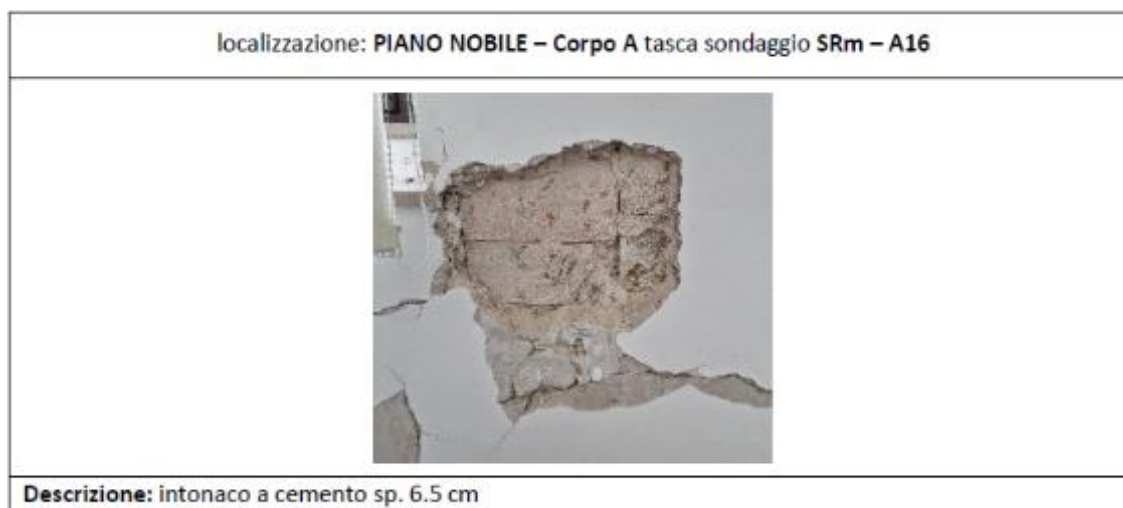
Figura 3.6 - Rimozione di intonaco sulla parete interna lato Quadriportico
