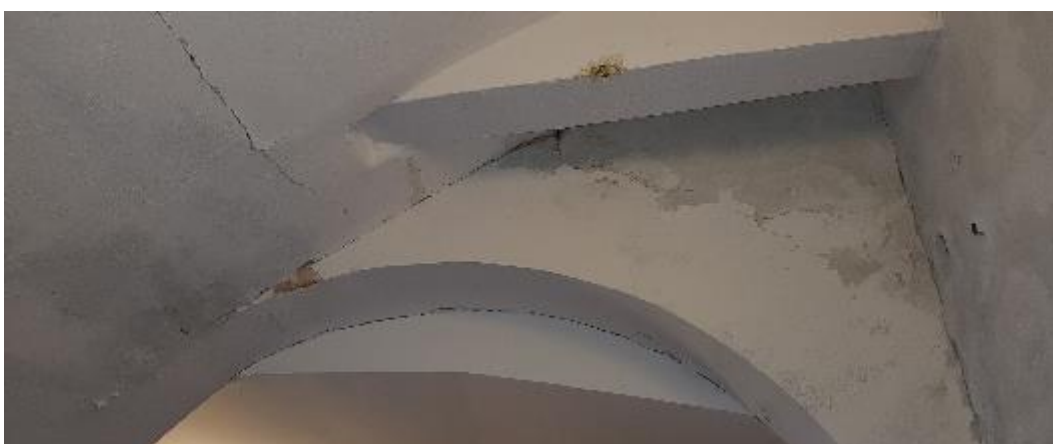
Figura 2.21 - Lesioni nei punti di collegamento tra il corpo scala e l'arcata superiore di un'apertura
