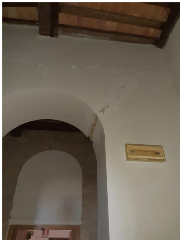
Figura 3.61 - Quadro fessurativo degli archi del piano Ammezzato
