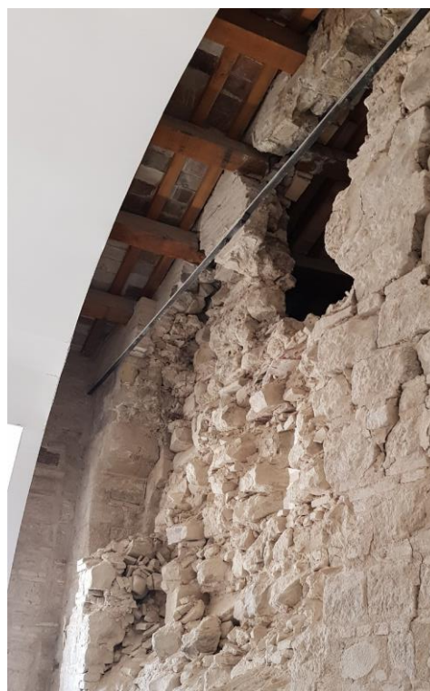
Figura 2.55 - Crollo della parte alta della parete: è ben visibile la separazione tra i due paramenti murari e il riempimento in materiale sciolto
