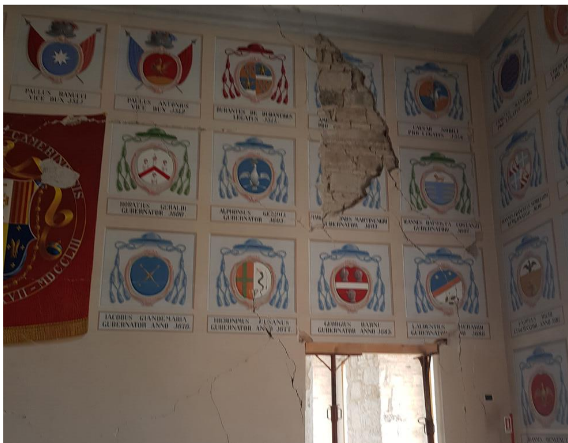
Figura 2.43 - Caduta di porzioni di intonaco dalle pareti
