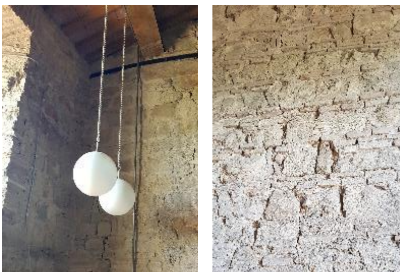
Figura 3.24 – Lesioni diffuse al vano scala
