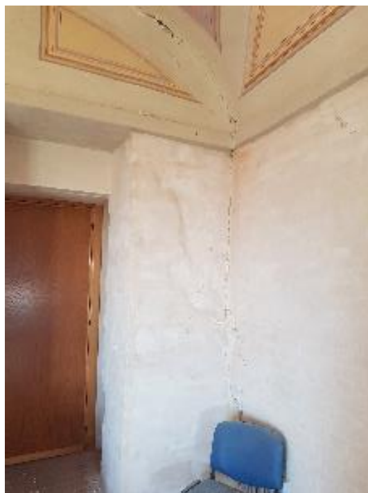
Figura 3.35 - Dettaglio del quadro fessurativo nel vano della scala a chiocciola
