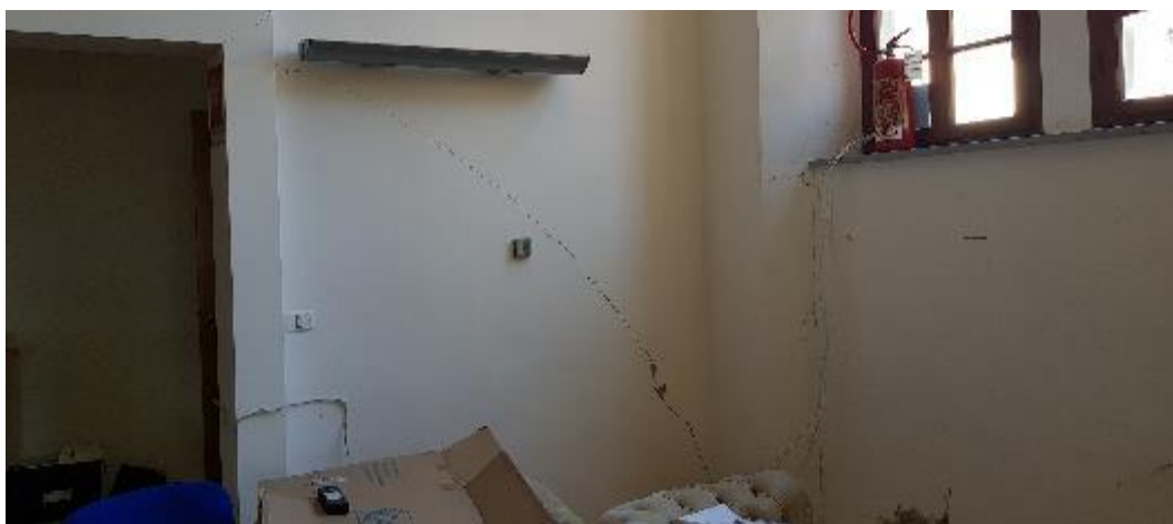
Figura 2.8 - Lesione legata al principio di ribaltamento della parete perimetrale lato portico
