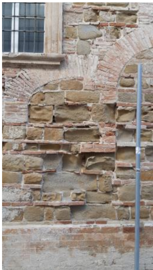
Figura 2.22 - Degrado superficiale dei blocchi di arenaria del paramento esterno della parete lato Piazza, con sensibile riduzione dello spessore degli elementi lapidei
