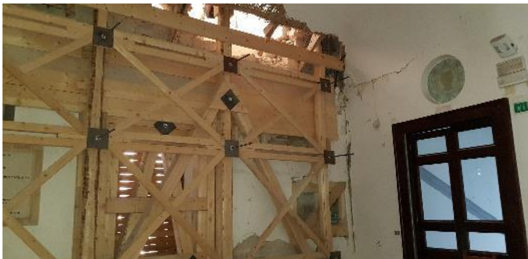
Figura 2.14 - Porzione di parete crollata vista dall'interno
