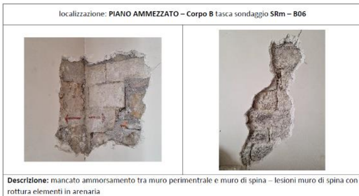
Figura 4.5 - Rimozione di intonaco in corrispondenza di uno spigolo delle pareti del Piano Ammezzato del Corpo B
