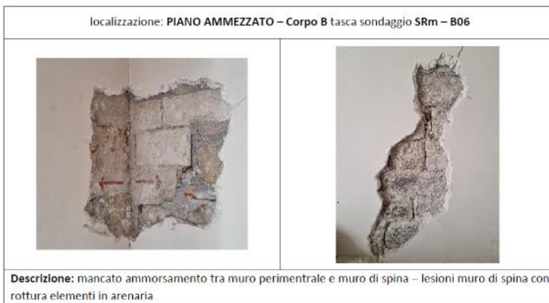
Figura 3.5 - Rimozione di intonaco in corrispondenza di uno spigolo delle pareti del Piano Ammezzato del Corpo B
