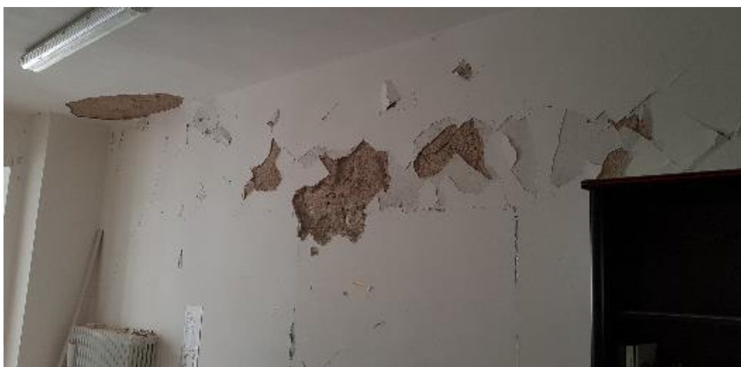
Figura 3.15 - Fessurazione lungo i bordi di nicchie richiuse
