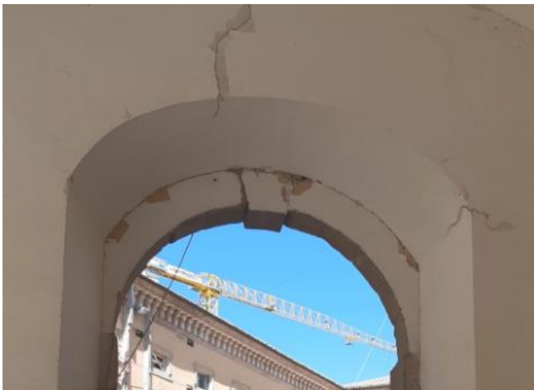
Figura 3.16 - Fessure per distacco dei due paramenti che costituiscono la parete lato Piazza
