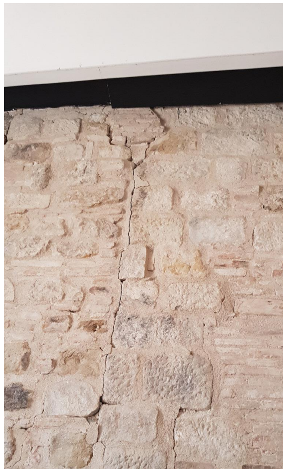
Figura 2.29 - Lesioni diffuse sulle pareti della torre
