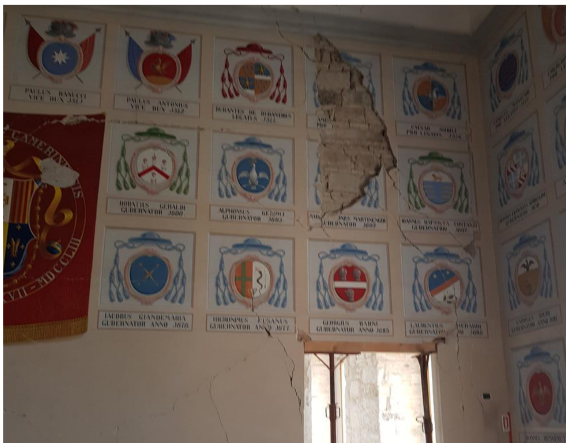
Figura 3.42 - Caduta di porzioni di intonaco dalle pareti
