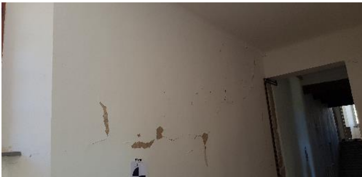
Figura 2.6 - Fessurazione diagonale su una parete del piano nobile
