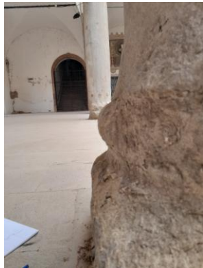
Perpendicolarità fra base e toro superiore
