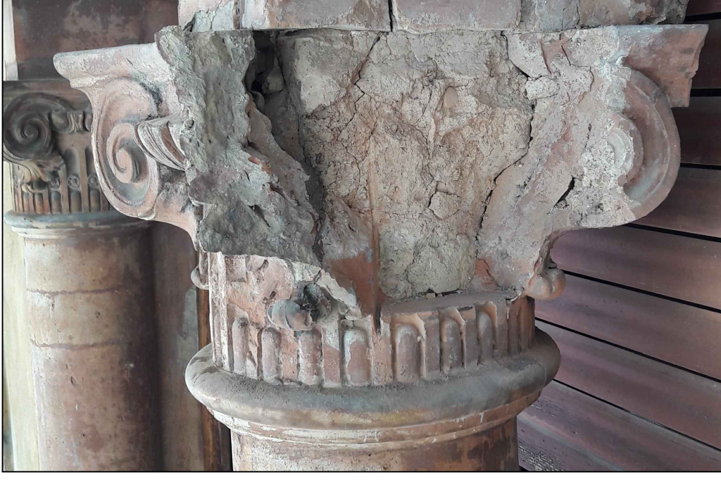
Foto B- Le condizioni conservative del capitello in seguito alla rimozione del primo intervento
