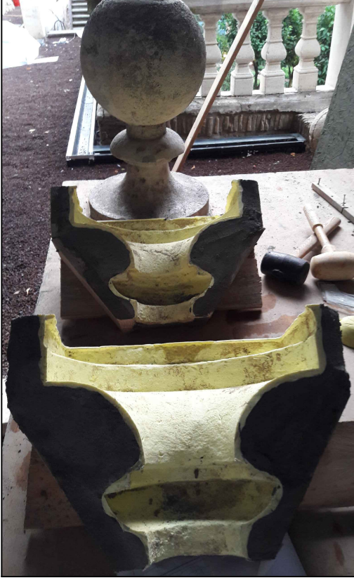
Foto I- La base ultimata grazie alle maschere di calco
