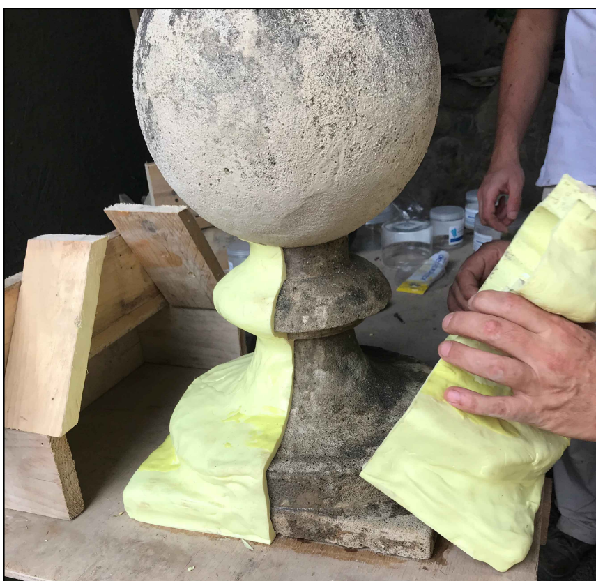
Foto H- Realizzazione della maschera negativa in silicone per un calco su un elemento decorativo lapideo integro
