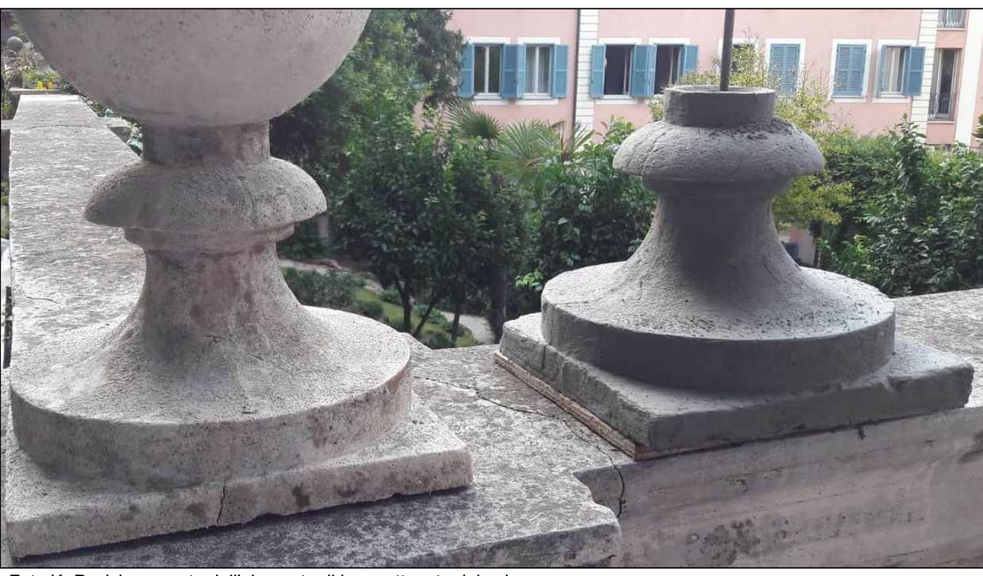
Foto K- Posizionamento dell'elemento di base ottenuto dal calco.
