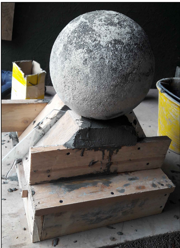
Foto G- Realizzazione del calco in cui è possibile vedere la cassa di contenimento e la struttura in gesso
