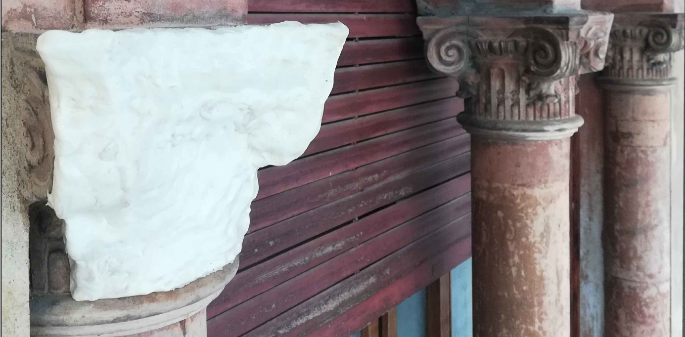
Foto C- Capitello soggetto alle operazioni di calco per poter integrare l'area lacunosa
