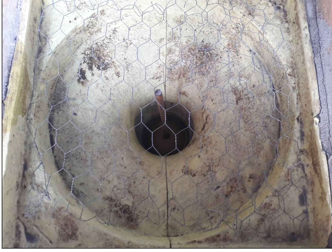
Foto J- Sistema di unione e stabilizzazione della base attraverso l'uso di un perno e una rete metallica
