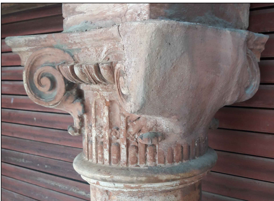
Foto A- Capitello soggetto ad un intervento eccessivamente invasivo, necessitante un'intervento di restauro.
