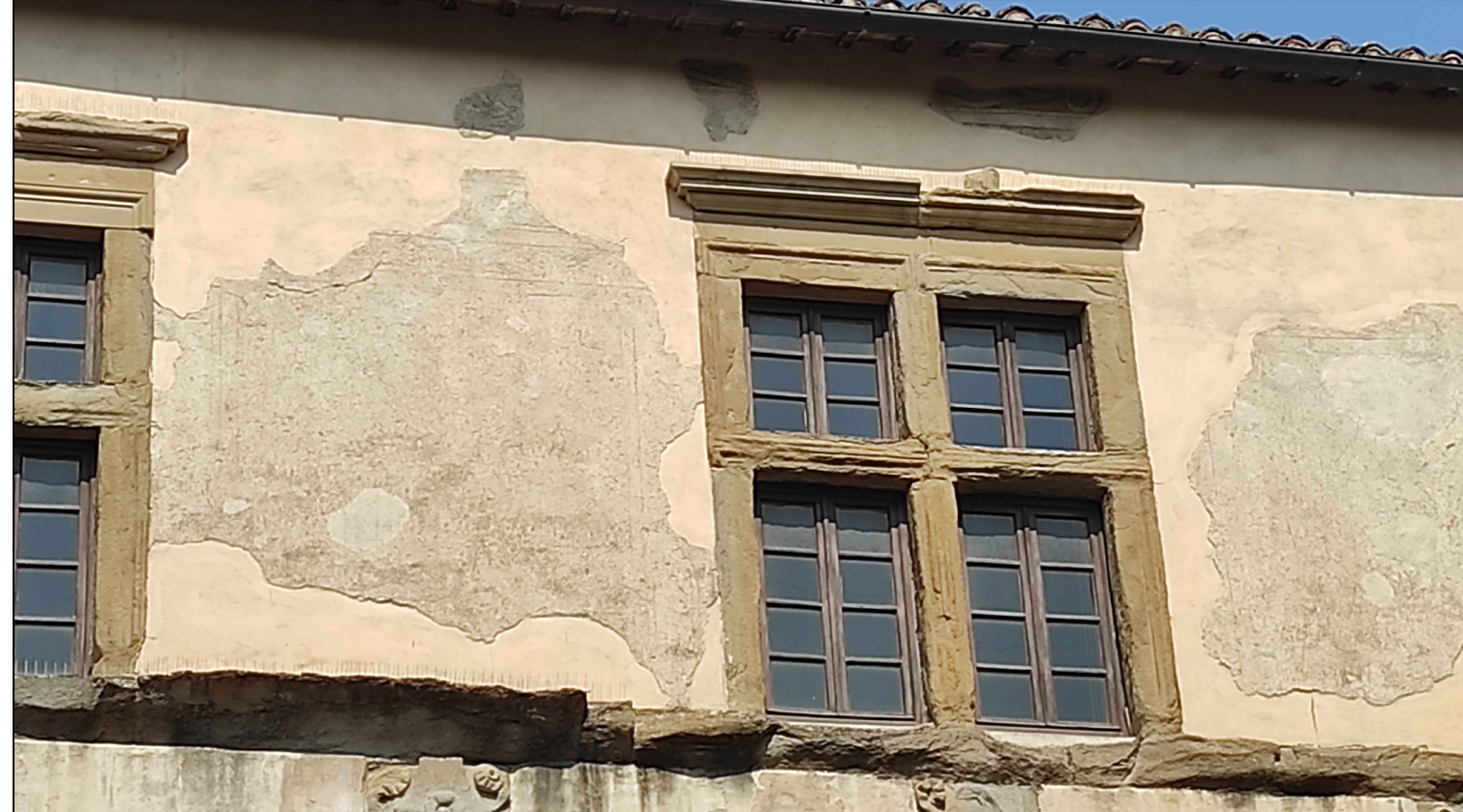
Figura 6. Quadriportico, dettaglio intonaco graffito lato Ovest.
