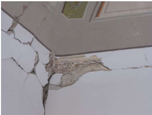
stanza A1 crolli parziali mettono in evidenza le fasce decorate all'imposta di volta
